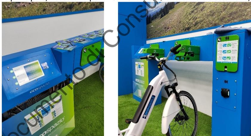
2. **Blocca bike:** sistema di bloccaggio bici al manubrio. La bici viene bloccata meccanicamente alla ciclostazione e rilasciata tramite l'accesso con Web APP e/o tessera RFID;
